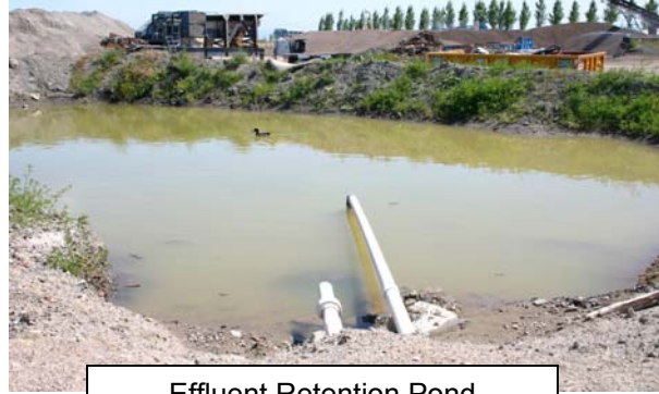
Effluent Retention Pond
